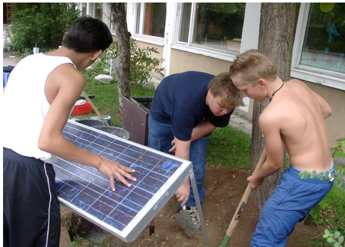
Bild 1: Hauptschüler bauen einen Solarbrunnen
